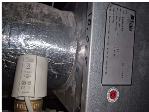
Régulateur terminal RXC de chez SIEMENS - Vanne de régulation SIEMENS + Ventilateur terminal – CURB
