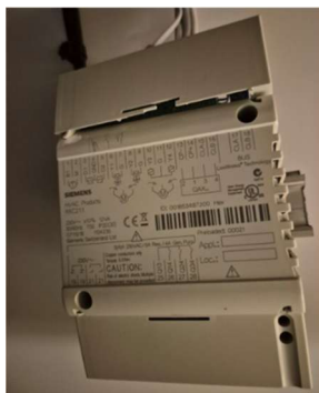
Régulateur terminal RXC de chez SIEMENS - Vanne de régulation SIEMENS + Ventilateur terminal – CURB
