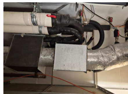
Régulateur terminal RXC de chez SIEMENS - Vanne de régulation SIEMENS + Ventilateur terminal – CURB
