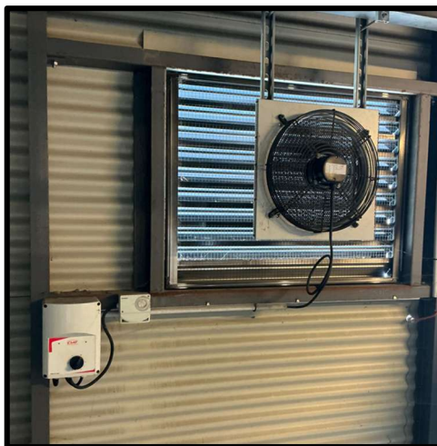
Ventilateur + régulateur autonome
